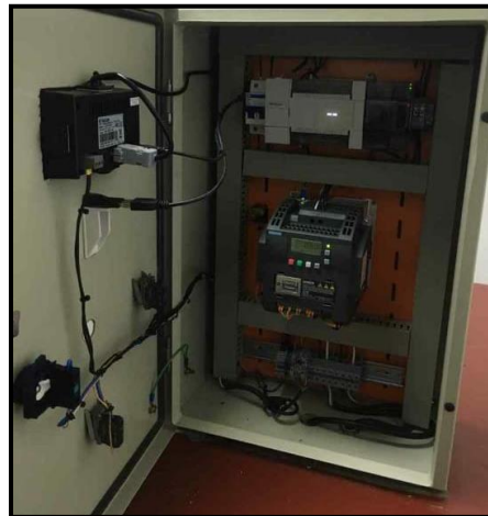
Figura 2.25 Ubicación de equipos sobre caja eléctrica.
