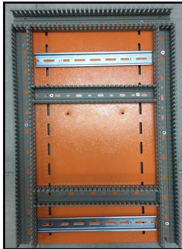
Figura 2.23 Instalación de rieles y canaletas
