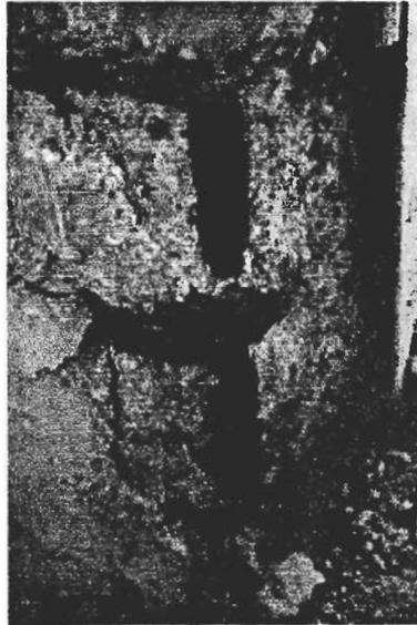
**FIGURA 1.6.4. PILOTE DE HORMIGÓN CARBONATADO.
