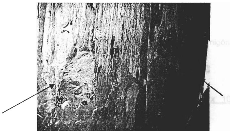
**FIGURA 2.3.5. EXTRACCIÓN DE HORMIGÓN PARA ENSAYO EN PANTALLA No. 4, LADO SUR, COTA + 0.900 MSNR, CARAS INTERIORES DERECHA E IZQUIERDA**
