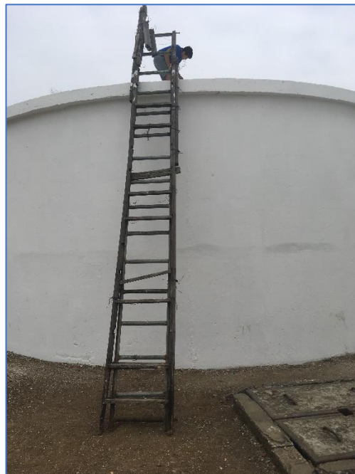
Figura 4.3: Escalera localizada en el reservorio.
