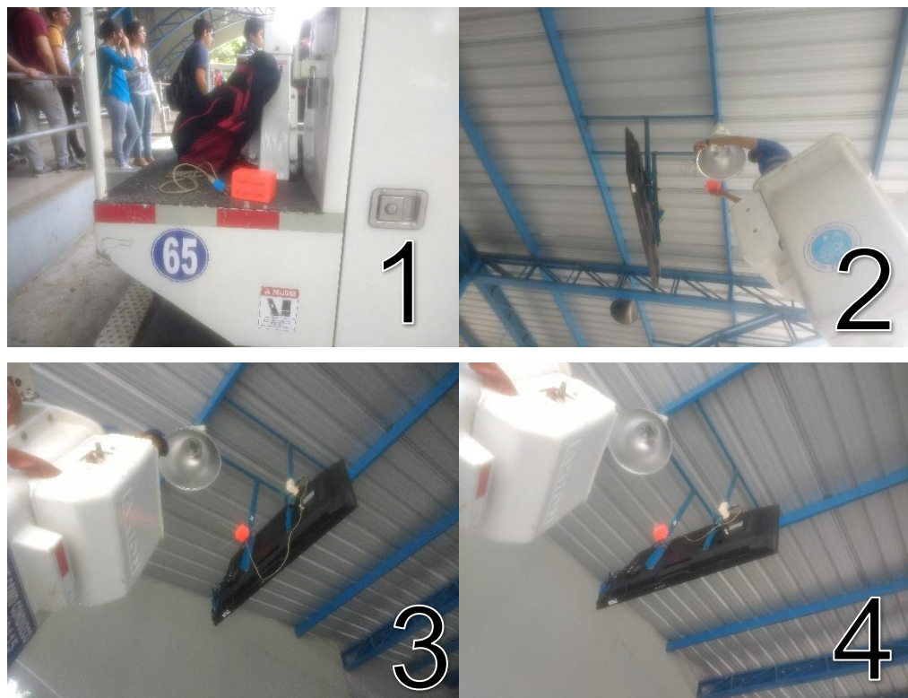
Figura 3.12 – Instalación del prototipo de pruebas.
