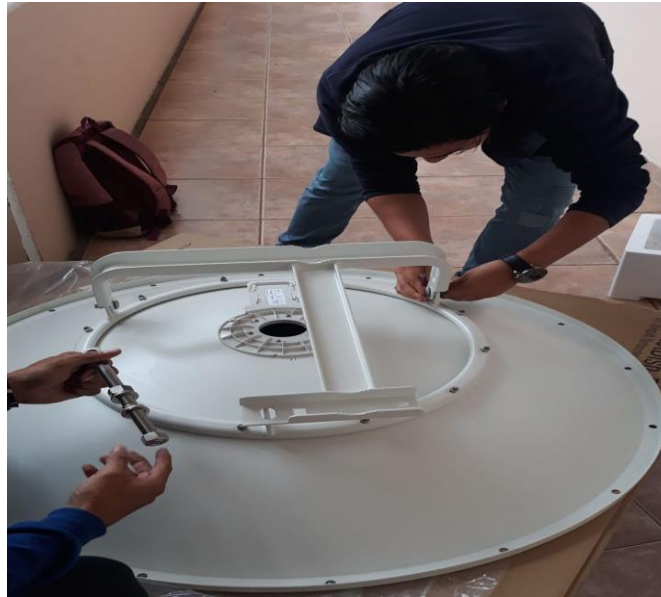
Figura 3.4 Armado de la Antena Parabólica
