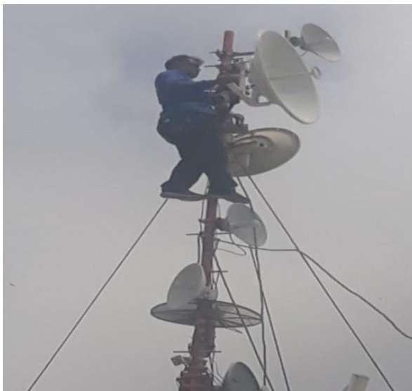
Figura 3.6 Instalación de antena transmisora en dirección correcta hacia antena receptora.
