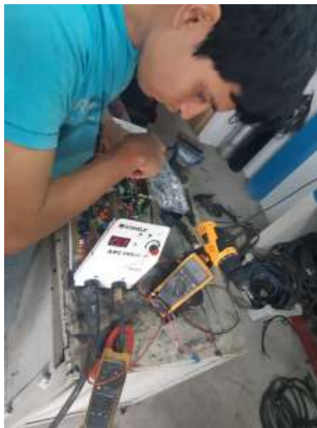
Figura 2.9 Medición de voltaje y corriente DC de la Soldadora ARC 300 ST.
