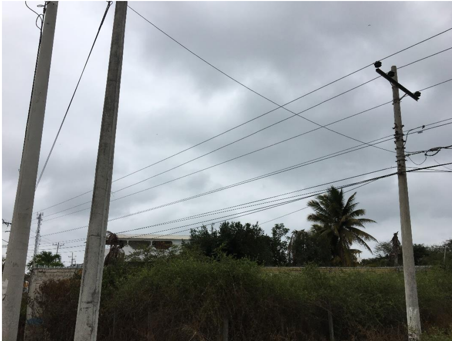
Anexo 3 Postes en la vía Data Posorja
