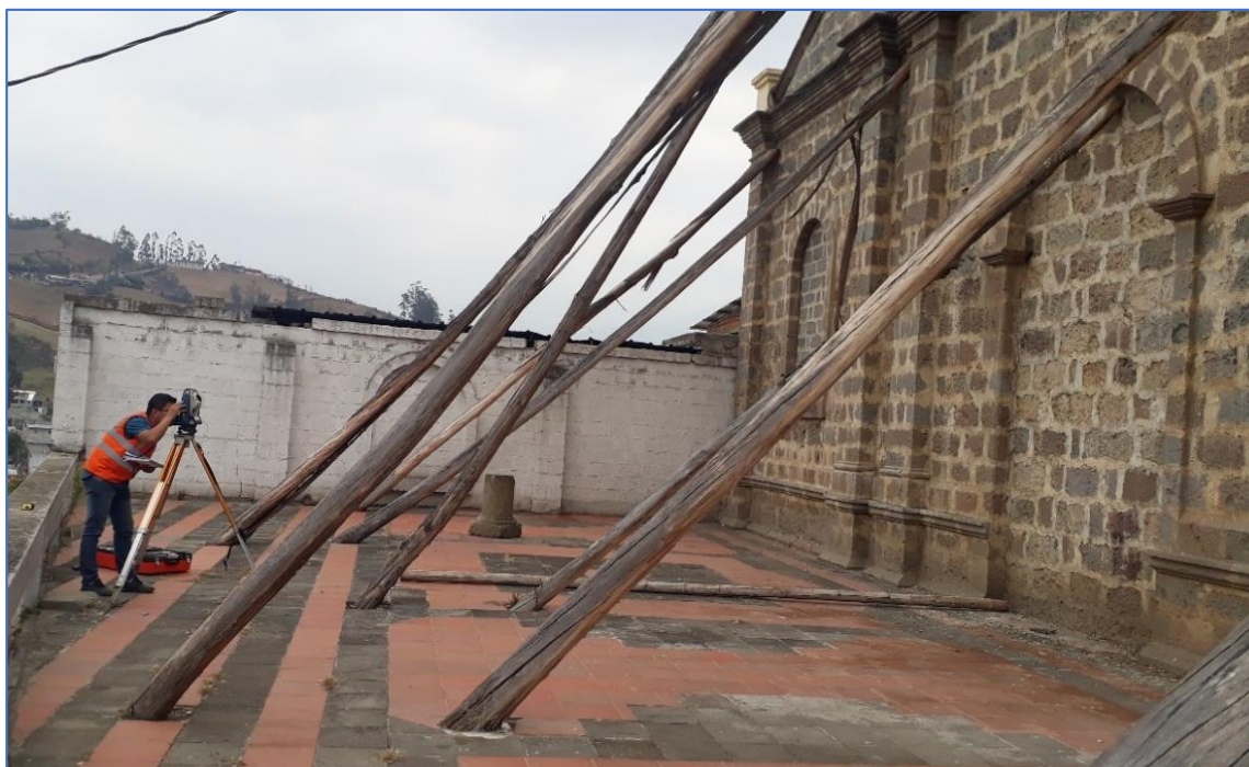
Figura 2.5 Prueba de verticalidad con la estación total.
