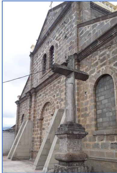
Figura 3.2 Sistema de refuerzo de la fachada posterior.
