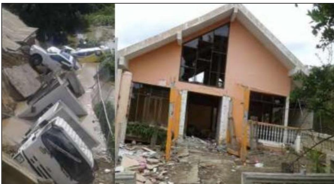
**Figura 1.9: Fallas de suelo debido a licuefacción ocurrida por Terremoto del 16 de abril de 2016, a la izquierda lateral spreads, a la derecha falla en cimentación ground oscillation failure, Portoviejo, Manabí.**
