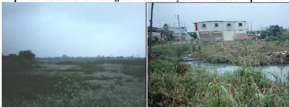
Figura # 36. Piscinas de oxidación de aguas servidas y canales naturales por donde se vierten las aguas residuales y domesticas de la población
