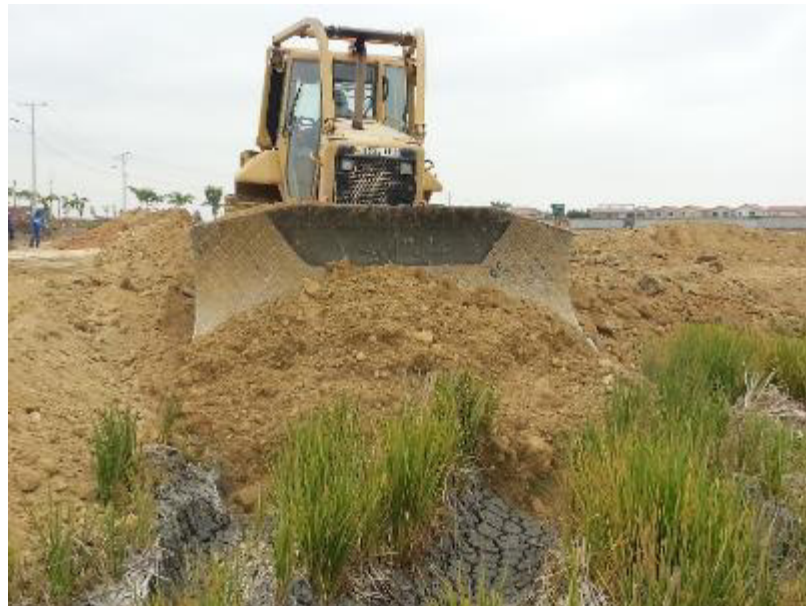
Figura 34. Tendido de material con ayuda D6 (tractor). Fuente Elaboración Autor
