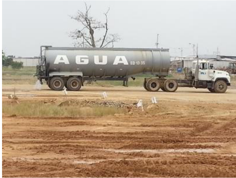
Figura 37. Hidratación de terreno, para evitar material particulado y compactación. Fuente Elaboración Autor
