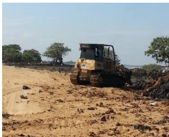
Figura 6 Tractor D6 realizando Desbroce de la capa vegetal. Fuente Elaboración Autor
