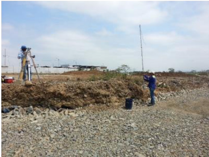
Figura 41. Equipo topográfico confirmación de cotas del terreno. Fuente Elaboración Autor
