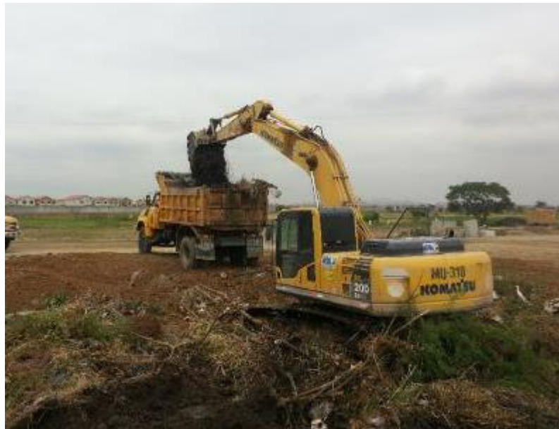
Figura 36. Retro de oruga, cargando material vegetal estoqueado para ser desalojado. Fuente Elaboración Autor
