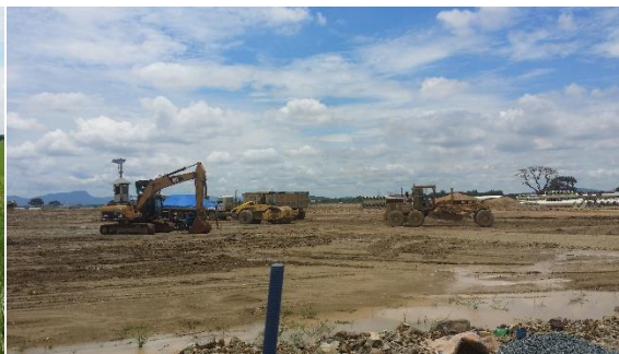
Figura 11. Zona urbana en el proceso constructivo. Fuente Elaboración Autor
