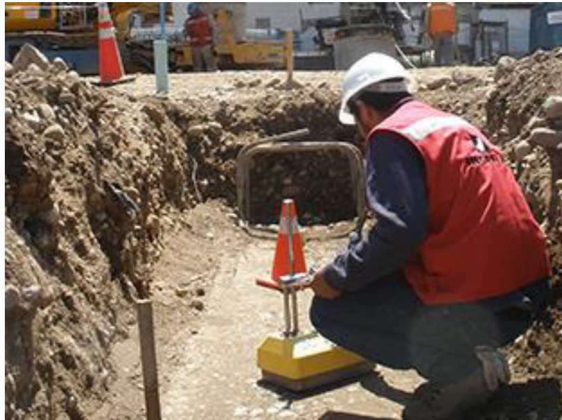
Figura 40. Comprobación de compactación con densímetro nuclear. Fuente Elaboración Autor
