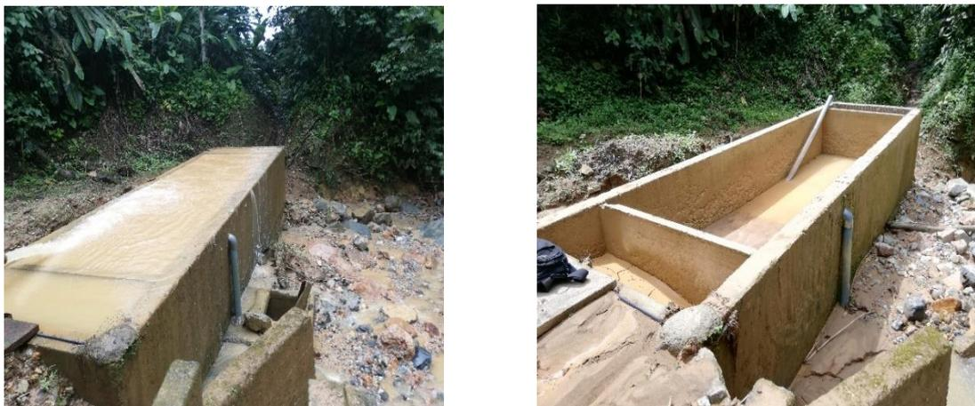
**Figura 1.10 Desarenador en el estero Cacauyacu. (Macas & Cajas, 2019)**
