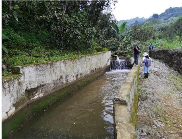
**Figura 1.6 Desarenador del estero del Pescado. (Macas & Cajas, 2019)**
