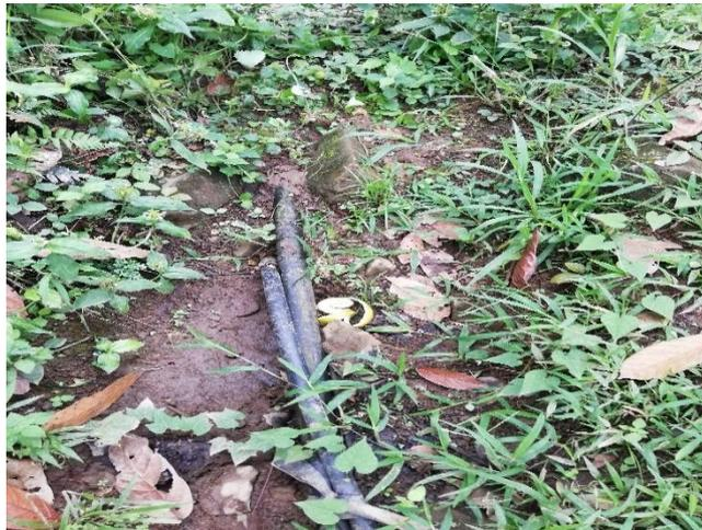
**Figura 1.7 Acometidas conectas a la tubería de 110 mm. (Macas & Cajas, 2019)**
