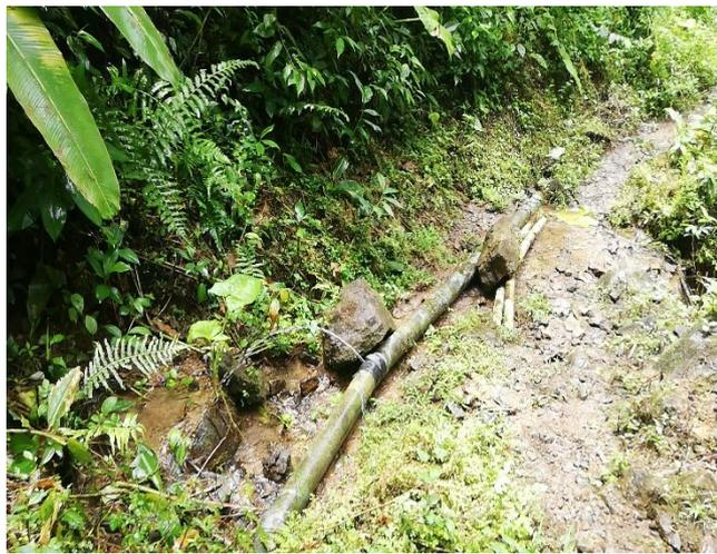
**Figura 1.9 Fugas en tubería de PVC de 63 mm. (Macas & Cajas, 2019)**
