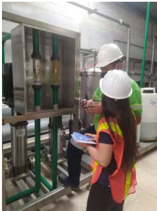
Anexo 8. Evaluación de los diferenciales de presión en la Planta de OI en Galapesca.
