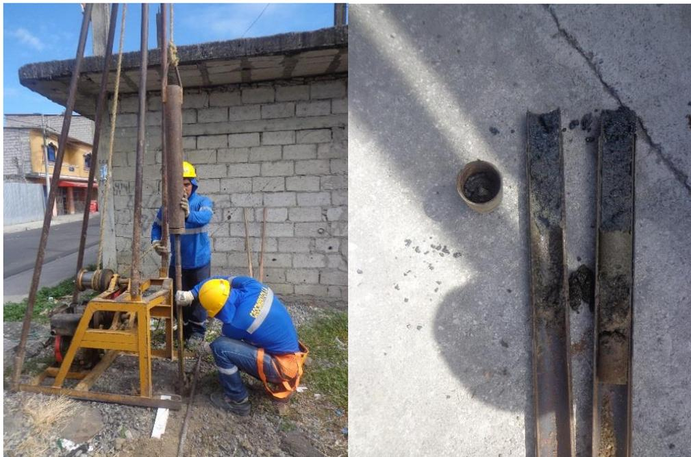
**Figura 2.26 Perforación del suelo en Trinitaria (Geocimientos, 2019)**
