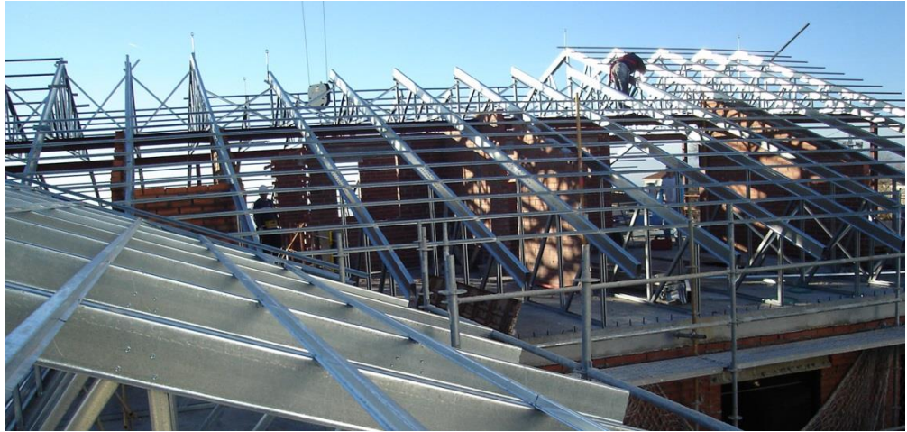
Figura 1.8 Viga Perfiles para cubiertas (Madrid)
