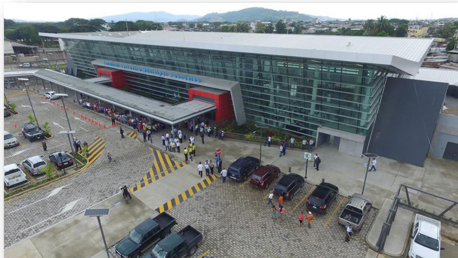
Figura 1.2 Terminal Terrestre de Pascuales (Mundo Constructor, 2016)
