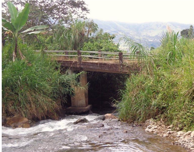
Ilustración 1.1.- Puente actual Cordoncillo - Loma Bonita. Fuente: GAD Atahualpa.
