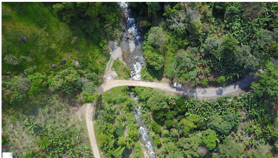
Ilustración 1.2.- Vista aérea del puente actual Cordoncillo - Loma Bonita. Fuente: GAD Atahualpa.
