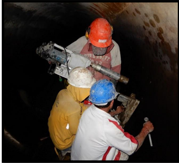
Figura 3.2 Extracción de muestras de hormigón. (Universidad de Cuenca - Empresa Pública)
