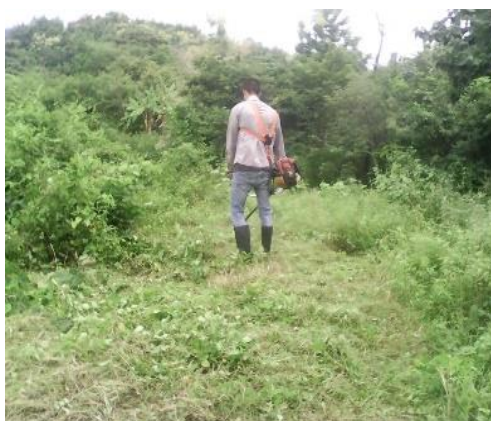
Foto 3. Preparación de terreno.
