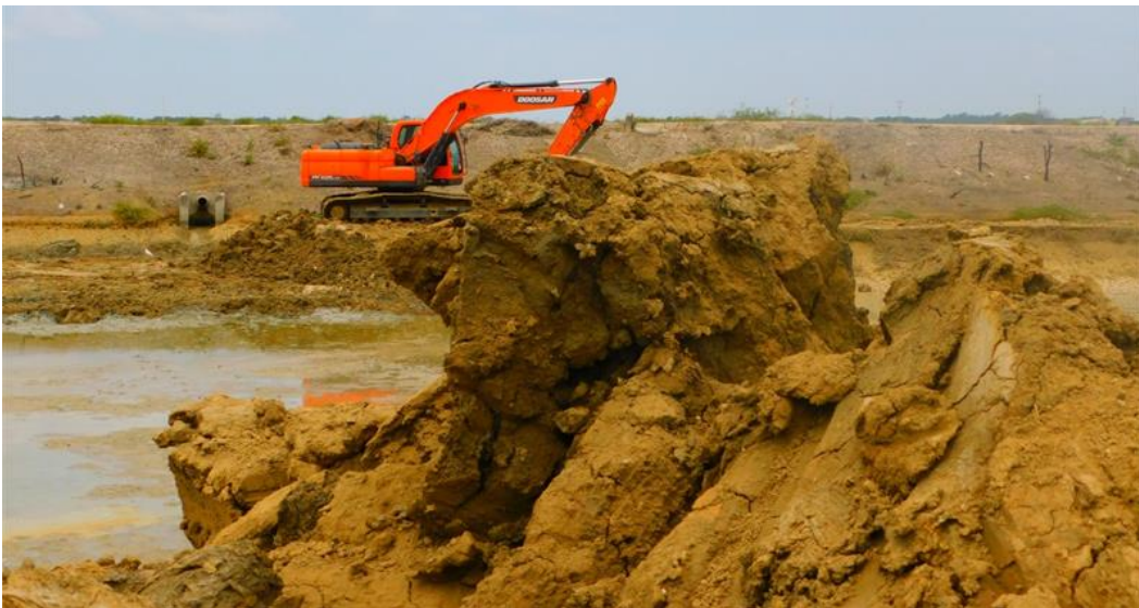
Figura 1.3 Excavación con maquinaria pesada [Autor: Tierra y Rodríguez]
