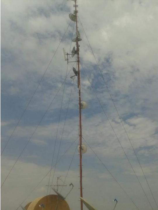
**Poste de Antenas Direccionales y Antenas Sectoriales**
