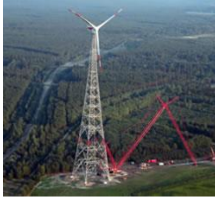
Figura 2.9. Torre de celosía más alta del mundo con 160 metros Fuente: (Mundoenergía, 2016)
