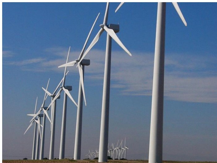
Figura 2.10. Torres tubulares con altura entre 20 y 30 metros Fuente: (Uruguay Natural Marca Pais, 2015)
