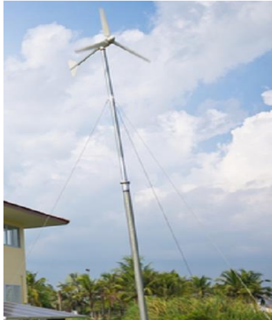
Figura 2.11. Torre de mástil tensado Fuente: (ITC, 2017)
