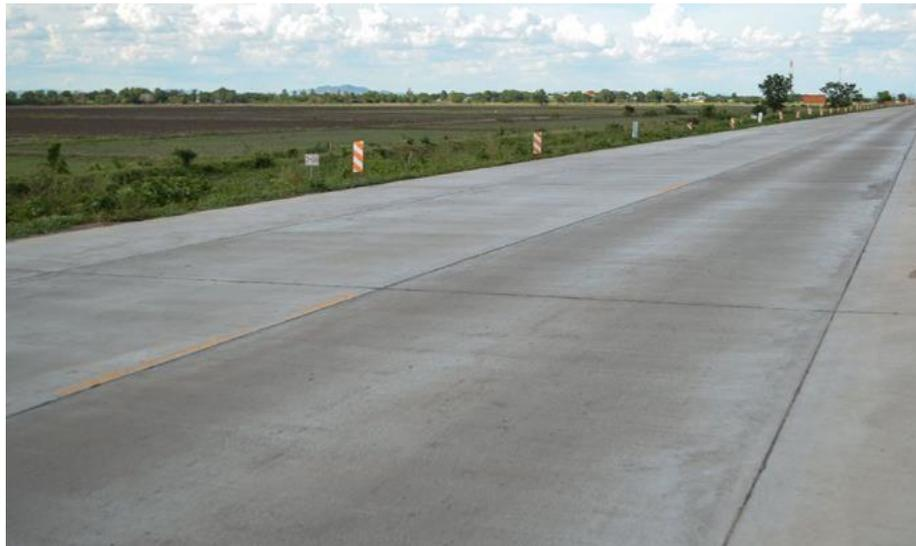
**Figura 1.21 Uso de un Pavimento Rígido (PSIconcreto, 2020)**
