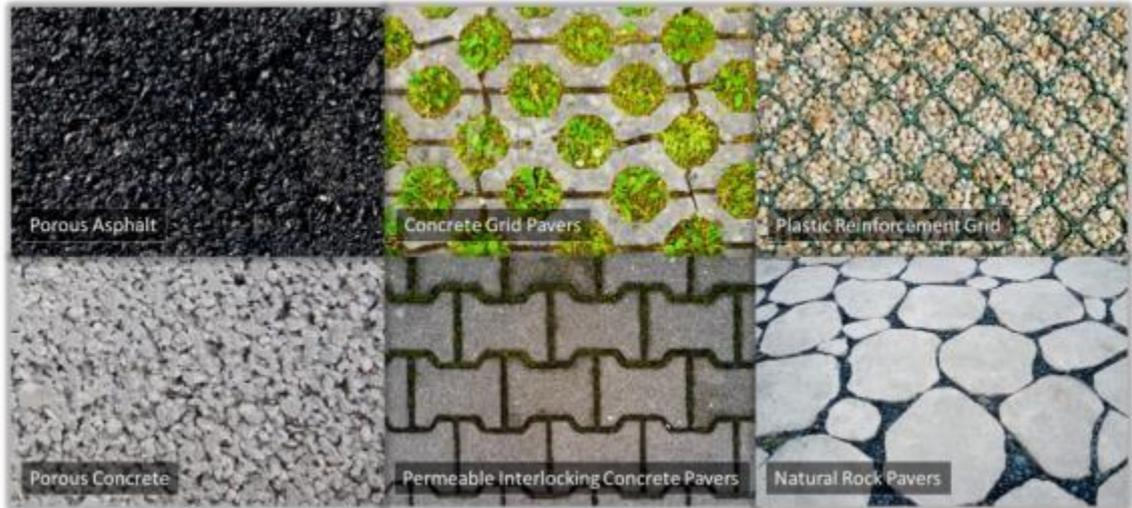
**Figura 1.25 Distintas Presentaciones del Pavimento Permeable (Sprouse et al., 2020)**
