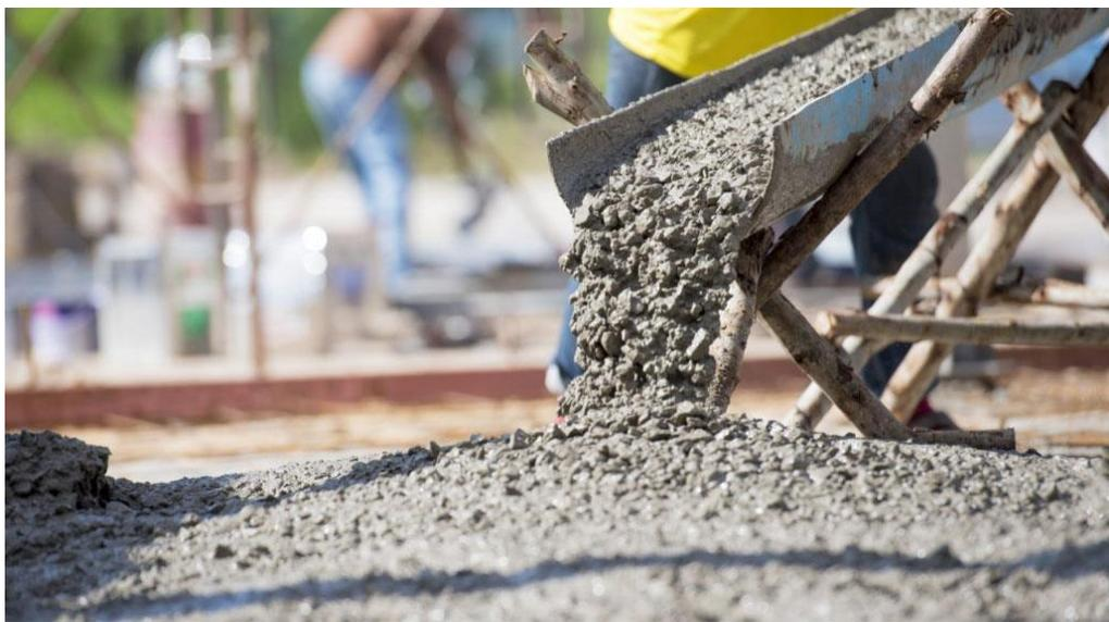
**Figura 1.9 Vertido directo del Hormigón (Pavex, 2019)**
