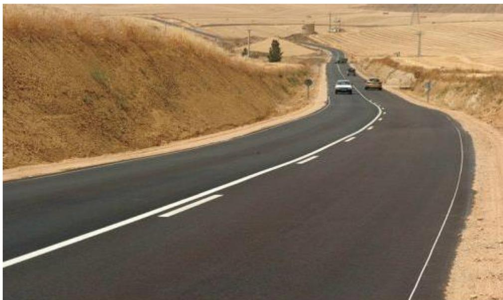
**Figura 1.18 Uso de un Pavimento Flexible (Suárez, 2018)**
