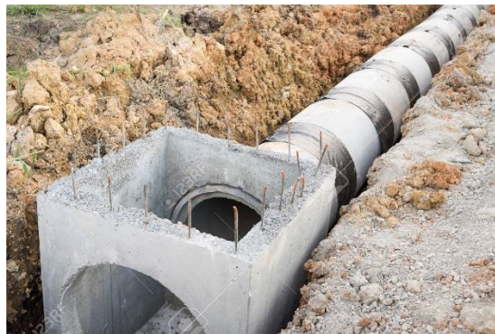
Figura 2.12: Pozo de inspección enterrado. Fuente: Archiexpo
