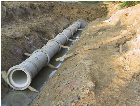
Figura 2.8: Tubería de hormigón prefabricado. Fuente: Prefabricados Alberdi
