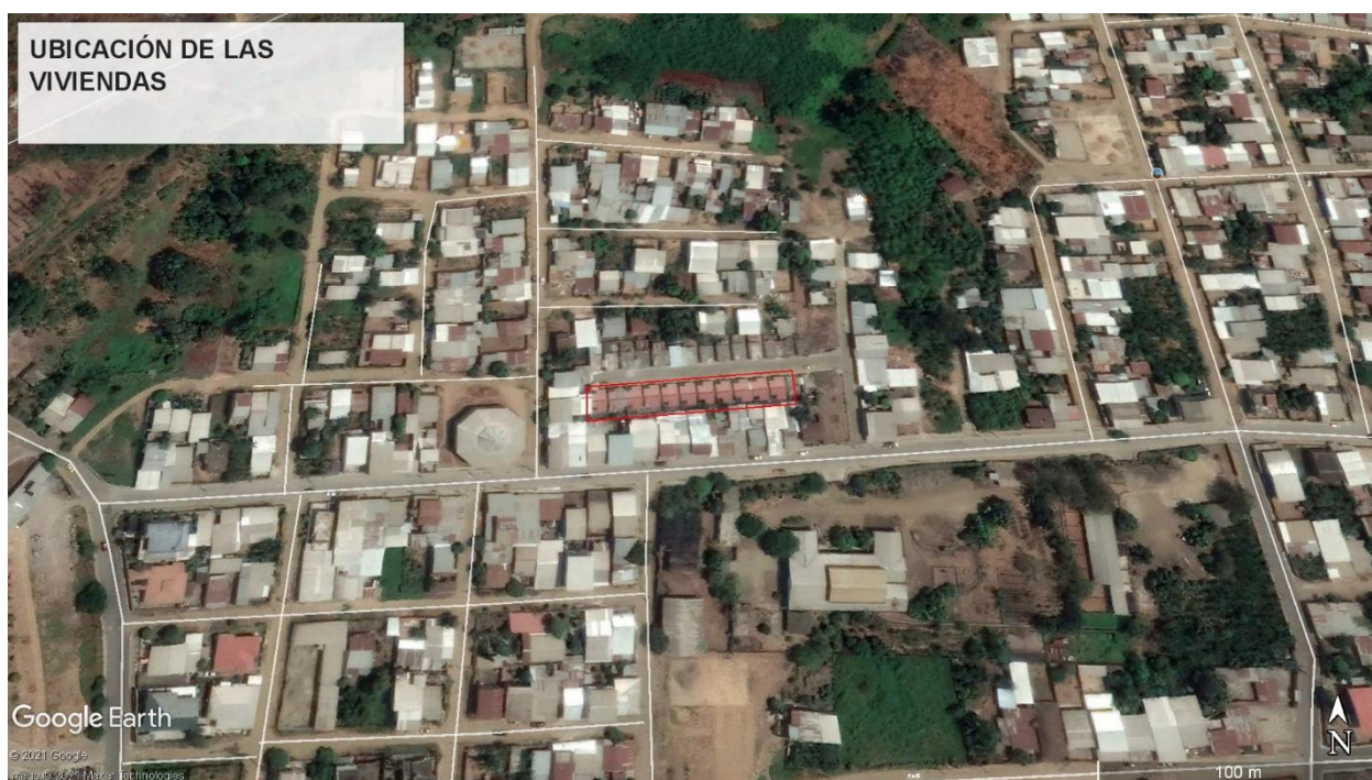
Ilustración 1.3 Vista de las 11 viviendas del proyecto “NUEVO RENACER”
