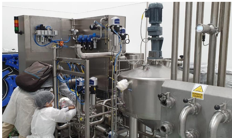
Figura 3. 23 Instalación del sistema de dosificación
