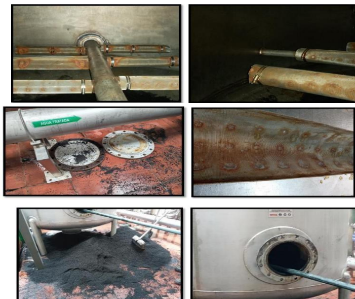
Figura 2. 22 Tanque de filtración por carbón activado antes de la mejora.
