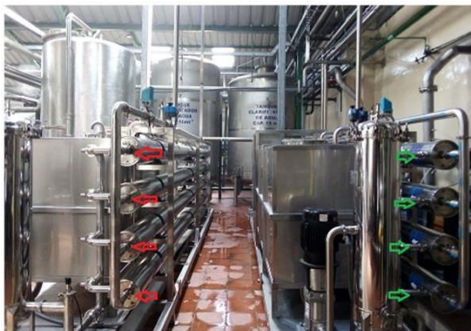
Figura 2. 6 Equipos de ósmosis inversa.
