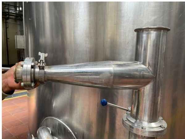
Figura 2. 28 Tubería luego del mantenimiento desincrustaciones.
