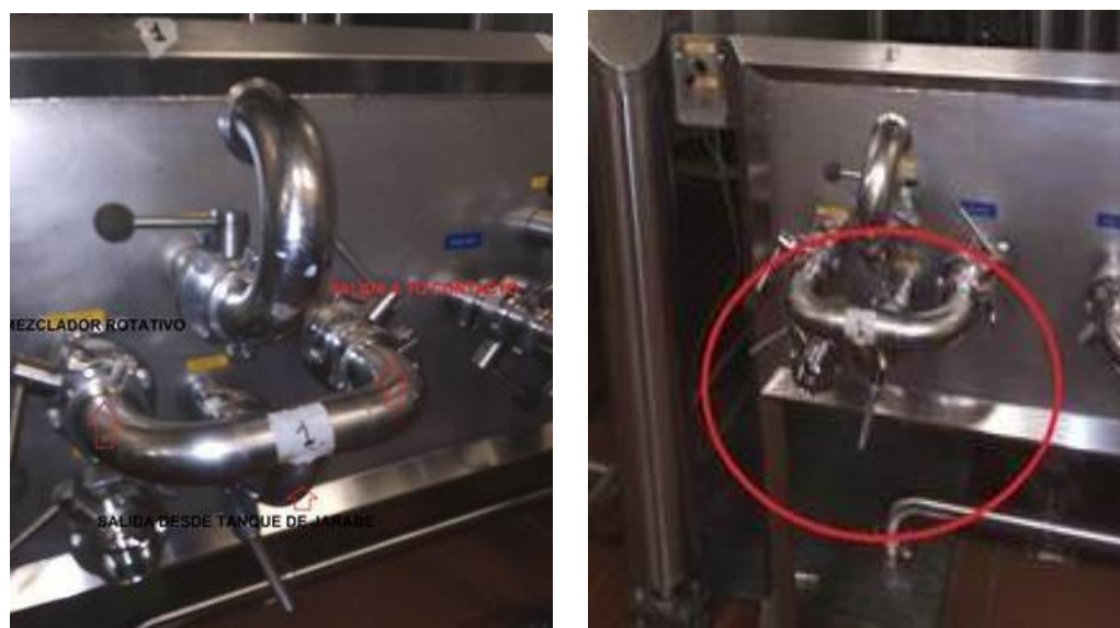
Figura 2. 29 Tubería con sistema de recirculación mejorado.
