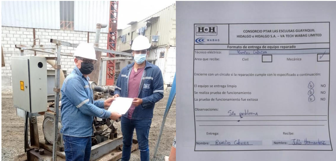
Figura 3.17 Entrega de generador al área mecánica
