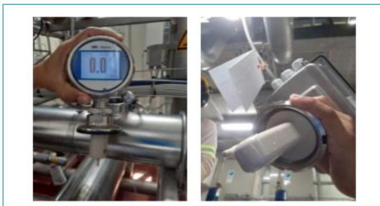
**Figura 2.15: Sensor de Conductividad CIP. Elaborado por: Katty Garcés, año 2021.**
