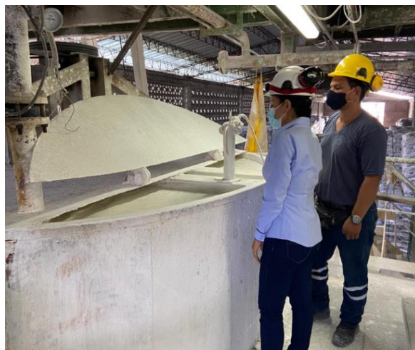
Figura 2.25: Supervisora de turno indicando al operador la manera correcta de medir la concentración de la muestra de lechada de cal
