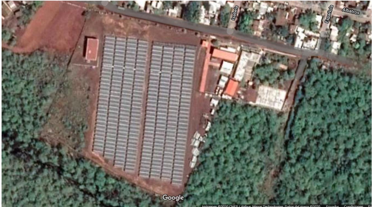
Ilustración 30. Vista de planta de la central fotovoltaica Puerto Ayora.
