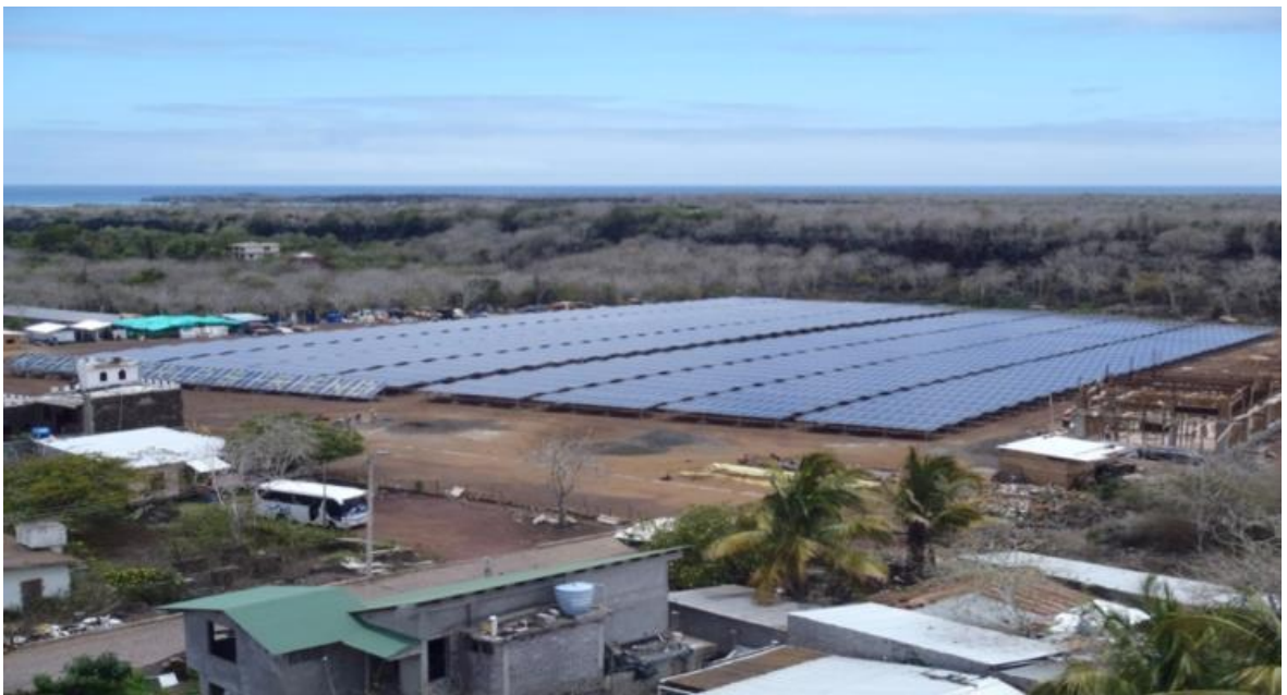
Ilustración 29. Central fotovoltaica Puerto Ayora.
