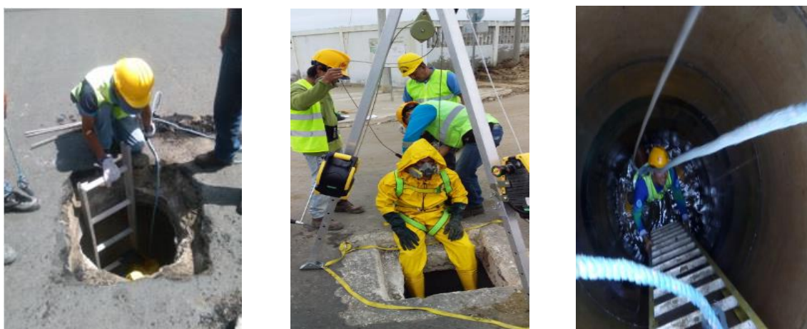
FIGURA 3.5 Limpieza de colectores de alcantarillados (Fuente: AGUAPEN-EP)
