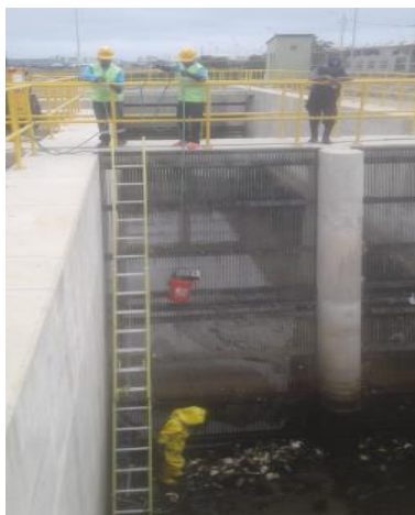
FIGURA 3.7 Limpieza de receptores y aguas lluvias (Fuente: AGUAPEN-EP)
