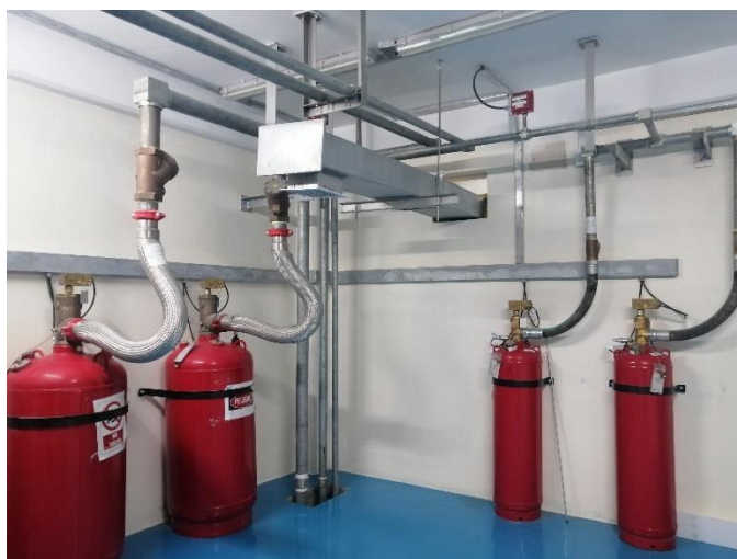
Figura 4.23 Sala de cilindros de agente FM 200
