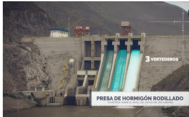
Figura 1.5. Vista frontal de la presa San Francisco
