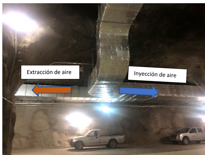
Figura 4.25 Ingreso y extracción de aire a casa de máquinas
