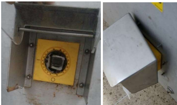
Figura 3.31 Interruptor de arranque de túnel averiado
