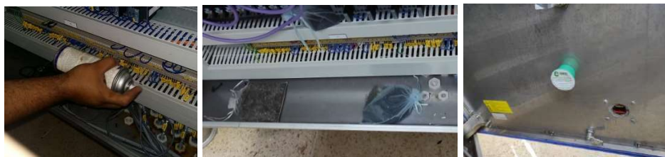
Figura 3.64 Implementación de protectores en tableros
