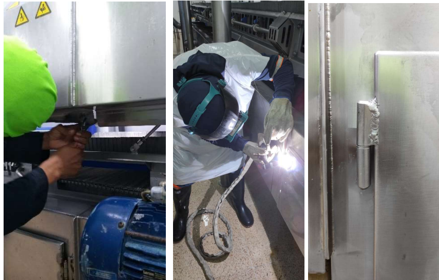
Figura 3.59 Correcciones en estructura de túneles
