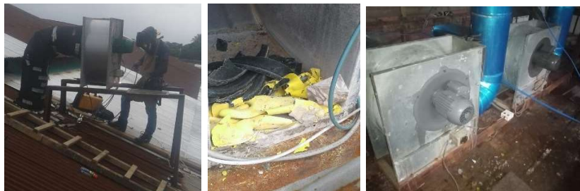
Figura 3.51 Mantenimiento y limpieza extractores
