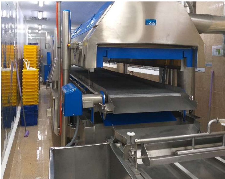
Figura 3.11 Hallazgo alrededor de túnel Durán 3
