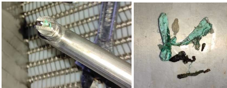
Figura 3.54 Limpieza interna de rociadores LIN
