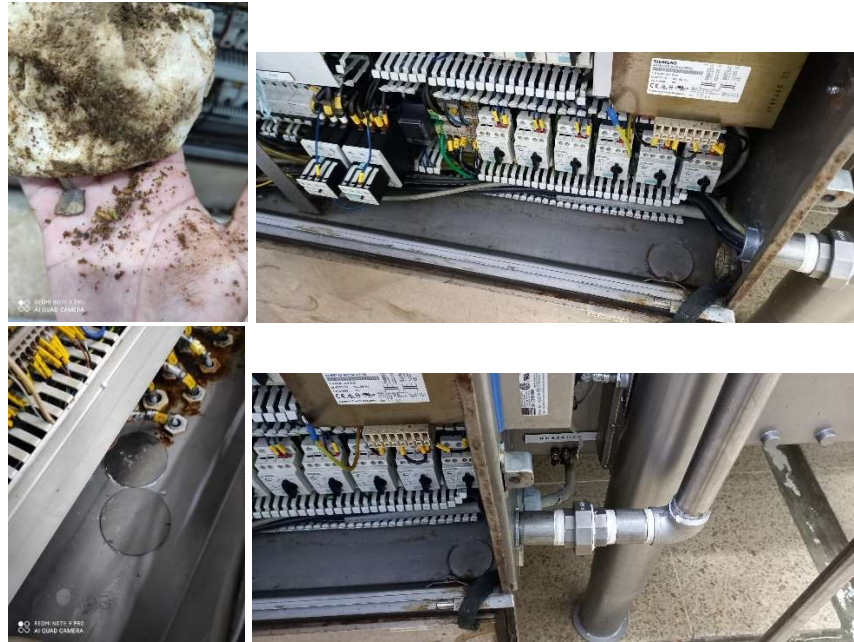
Figura 3.47 Mejora de filtración y limpieza tableros
