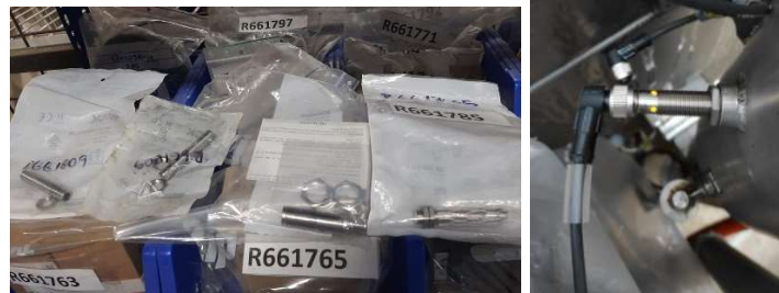
Figura 3.49 Reemplazo de sensores de posición de túnel
