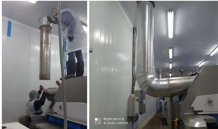
Figura 3.58 Reemplazo de tramos de tubería de extracción
