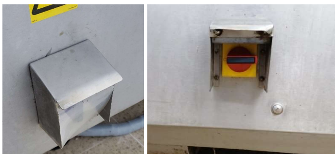
Figura 3.46 Reemplazo de interruptores de arranque
