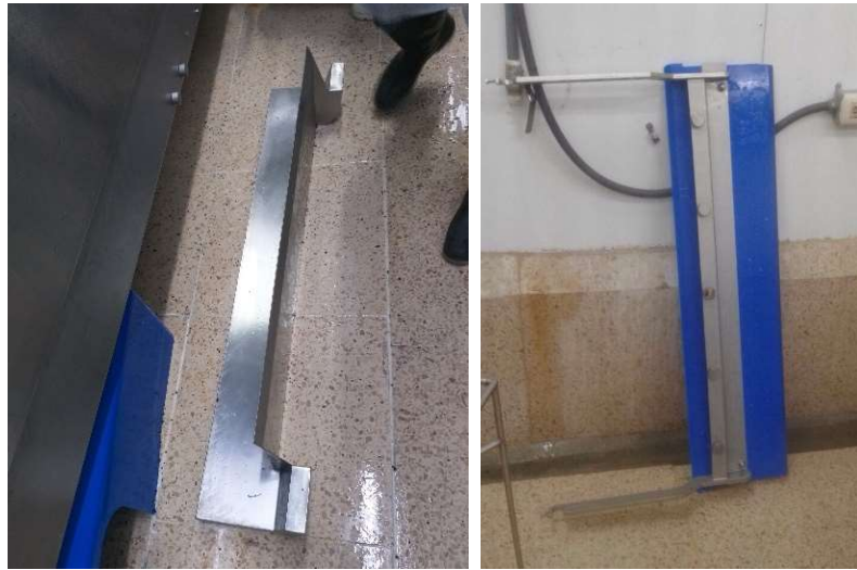
Figura 3.13 Elementos cobertores y retención de Durán 2
