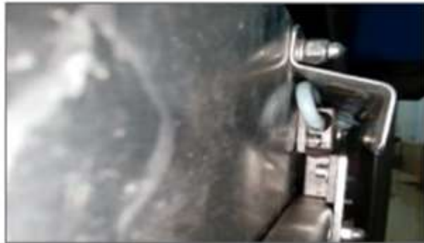
Sensor con problema en su base ya que se presenta doblada en ambos túneles.
