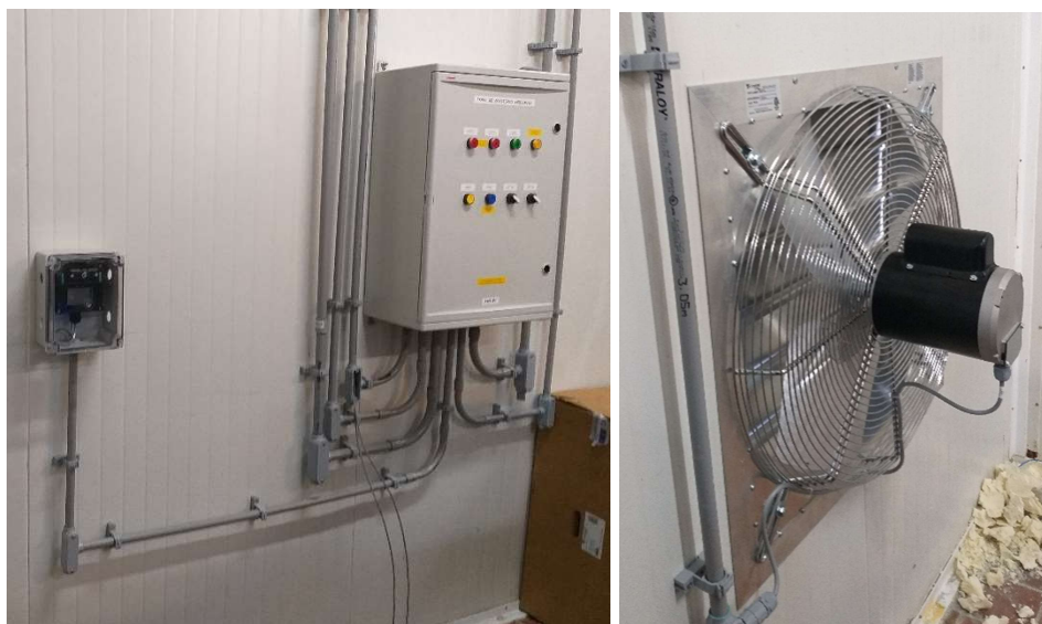
Figura 4.1 Sistema de monitoreo de oxígeno
