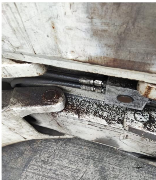
Figura 3.34 Montacarga con fuga de aceite (Fuente: Investigación de campo)
