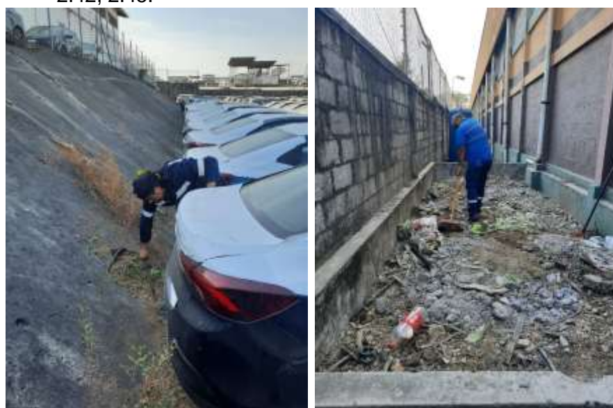
FIGURA 2.42 LIMPIEZA REALIZADA EN EXTERIORES DE BODEGA 2 Y PATIOS.
