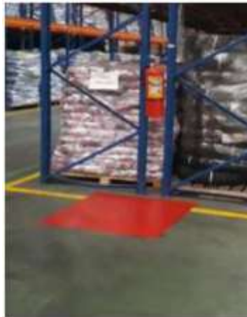
FIGURA 2.37 SEÑALIZACIÓN DE EXTINTORES. (Fuente: La empresa)
