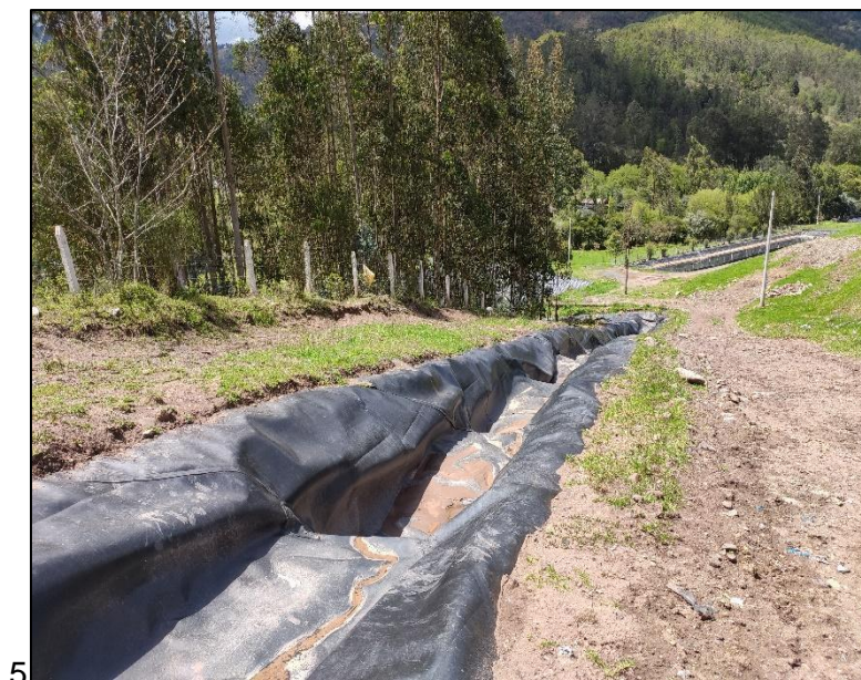
Figura 3.4 Canales para aguas lluvias
