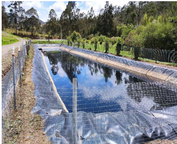
Figura 3.3 Piscina de lixiviados
