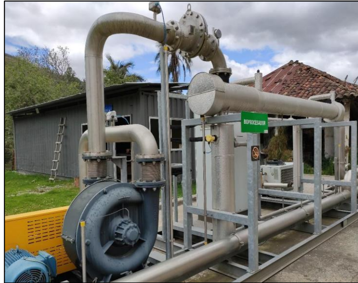
Figura 3.9 Bioprocesador, procesamiento del biogás, BGP
