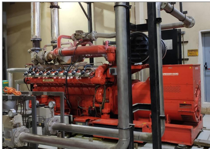
Figura 3.10 Motor de combustión interna, BGP.
