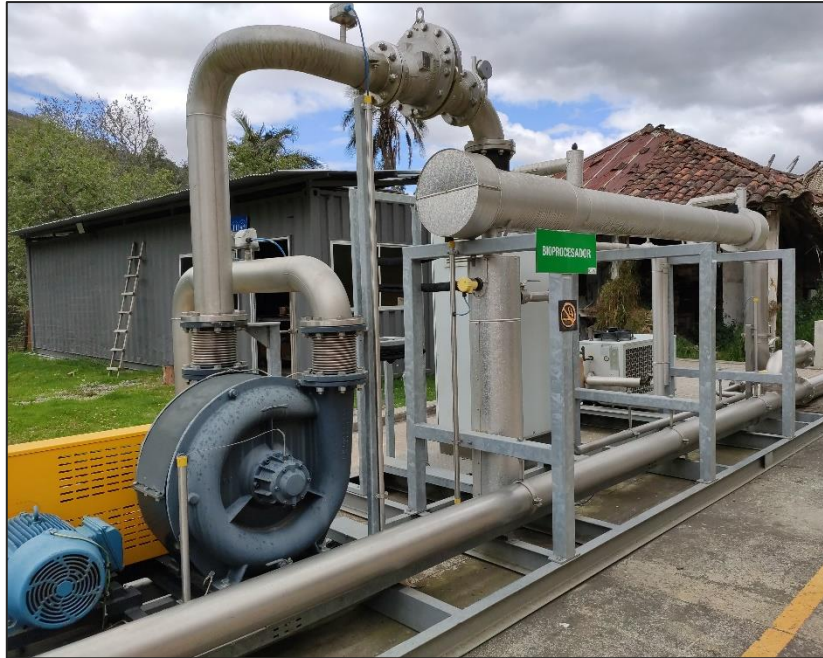
Figura 3.6 Procesador de biogás
