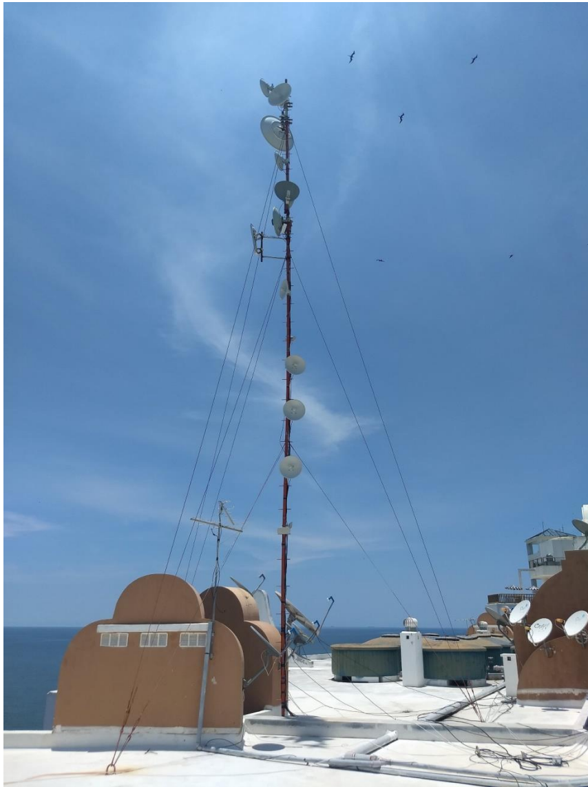
Figura 3.3 Torres con radioantenas Cambium Networks ePMP Force 200 5 GHz
