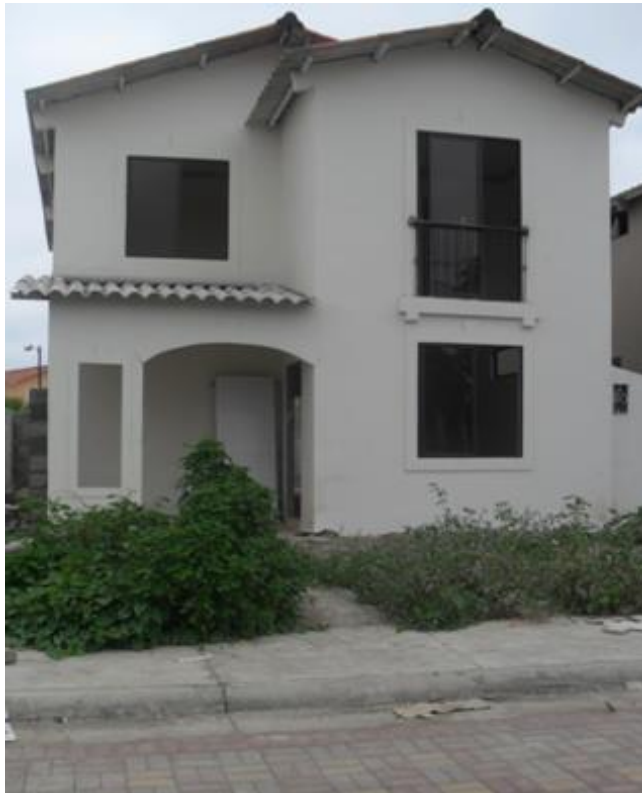
Ilustración 4: Rincón de Castilla - Vivienda Frente
