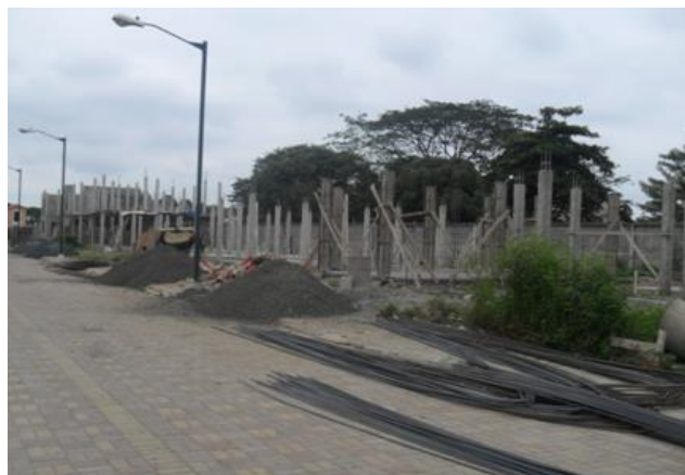
Ilustración 5: Rincón de Castilla - Viviendas en construcción
