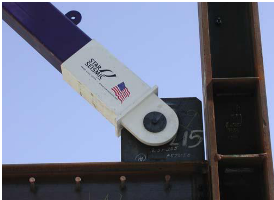
Figura 2.28. Conexión articulada (o con pasador) de un APR (Hussain, et al., 2006)
