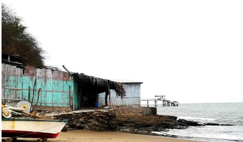
Figura 1.2 Viviendas en la parte baja del acantilado. Fuente (Rivas, J., 2019)
