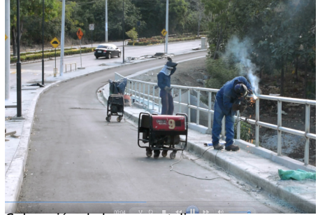
Colocación de barras metálicas Carril de la Ciclovía
