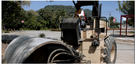
Construcción Carril Ciclovía
