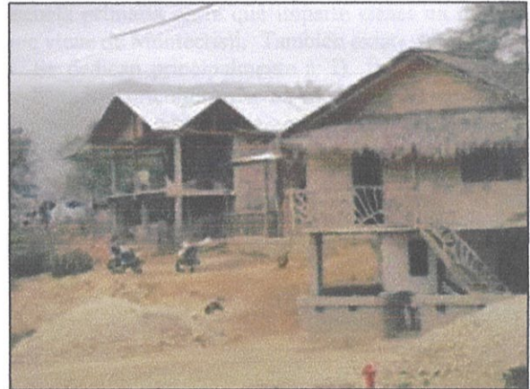
Figura 7. Viviendas en Agua Blanca
