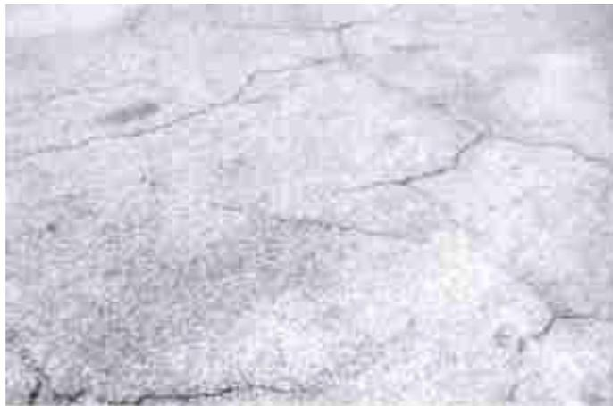
**FOTO No.2.2.- Fisura de Alto Nivel**
