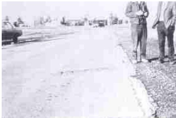
**FOTO No. 4.12.- Falla Desnivel Localizado – Severidad Alta**
