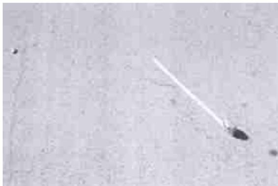
**FOTO No. 4.48.- Falla Fisuramiento de Resbalamiento – Severidad Media**
