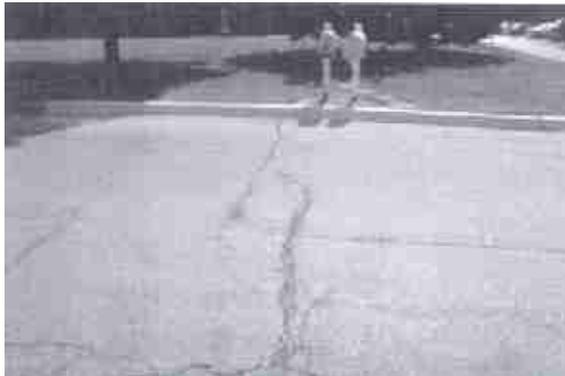
**FOTO No. 4.9.- Fisuramiento en Bloque – Severidad Alta**
