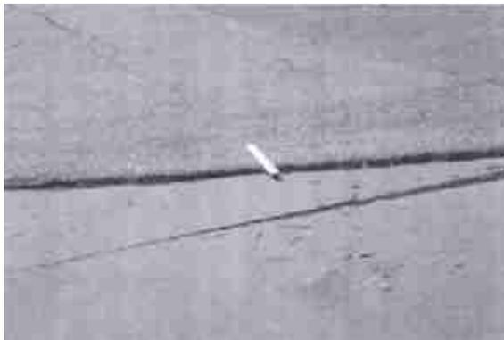
**FOTO No. 4.46.- Falla Desplazamiento – Severidad Alta**
