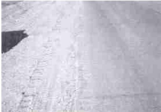
**FOTO No. 4.23.- Falla Fisuramiento de Reflexión – Severidad Media**
