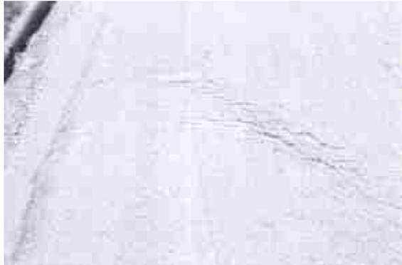
**FOTO No. 4.49.- Falla Fisuramiento de Resbalamiento – Severidad Alta**
