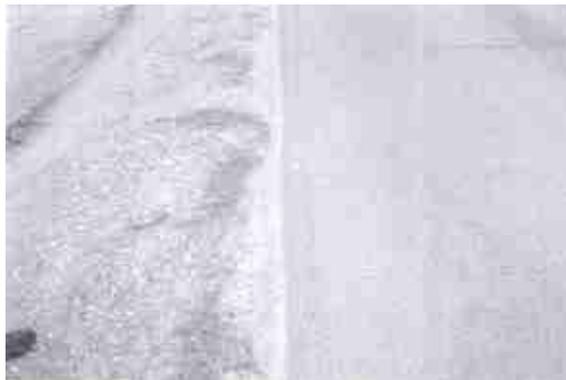
**FOTO No. 4.20.- Falla Fisuramiento en Borde – Severidad Media**
