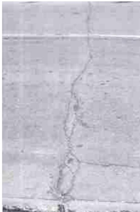
**FOTO No. 4.24.- Falla Fisuramiento de Reflexión – Severidad Alta**
