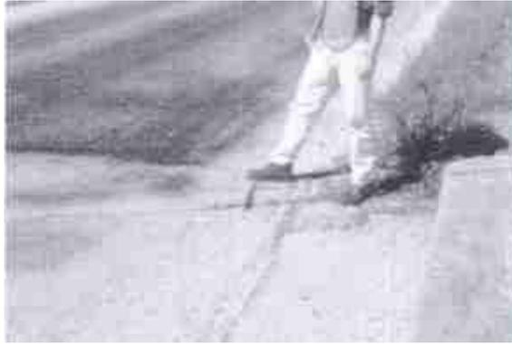
**FOTO No. 4.45.- Falla Desplazamiento – Severidad Media**
