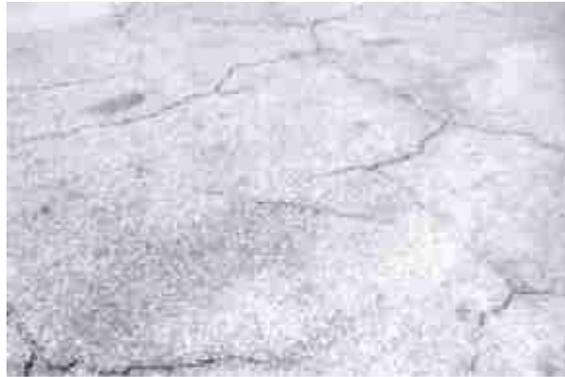
**FOTO No. 4.8.- Fisuramiento en Bloque – Severidad Media**
