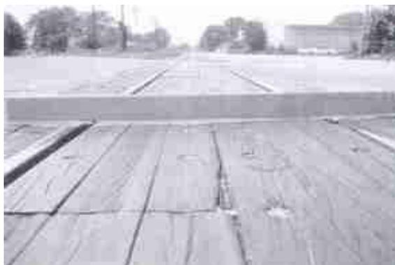
**FOTO No. 4.39.- Falla Cruce de Ferrocarril – Severidad Media**
