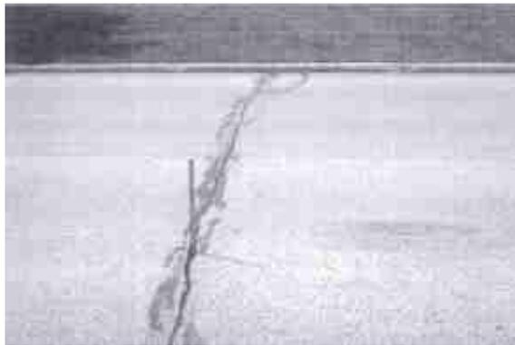
**FOTO No. 4.30.- Falla Fisuramiento Longitudinal y/o Transversal –
