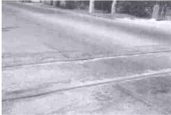
**FOTO No. 4.40.- Falla Cruce de Ferrocarril – Severidad Alta**
