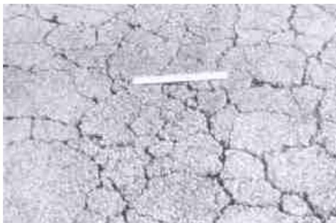
La aparición de fisuras es el primer aviso de una carretera con problemas. Es indicio de tensiones, debidas a condiciones climáticas o de cargas de tráfico que han sobrepasado los límites de la resistencia del firme o a problemas con la explanada. Es la señal para el ingeniero de que los costos de conservación se van a disparar si no se actúa con prontitud.
