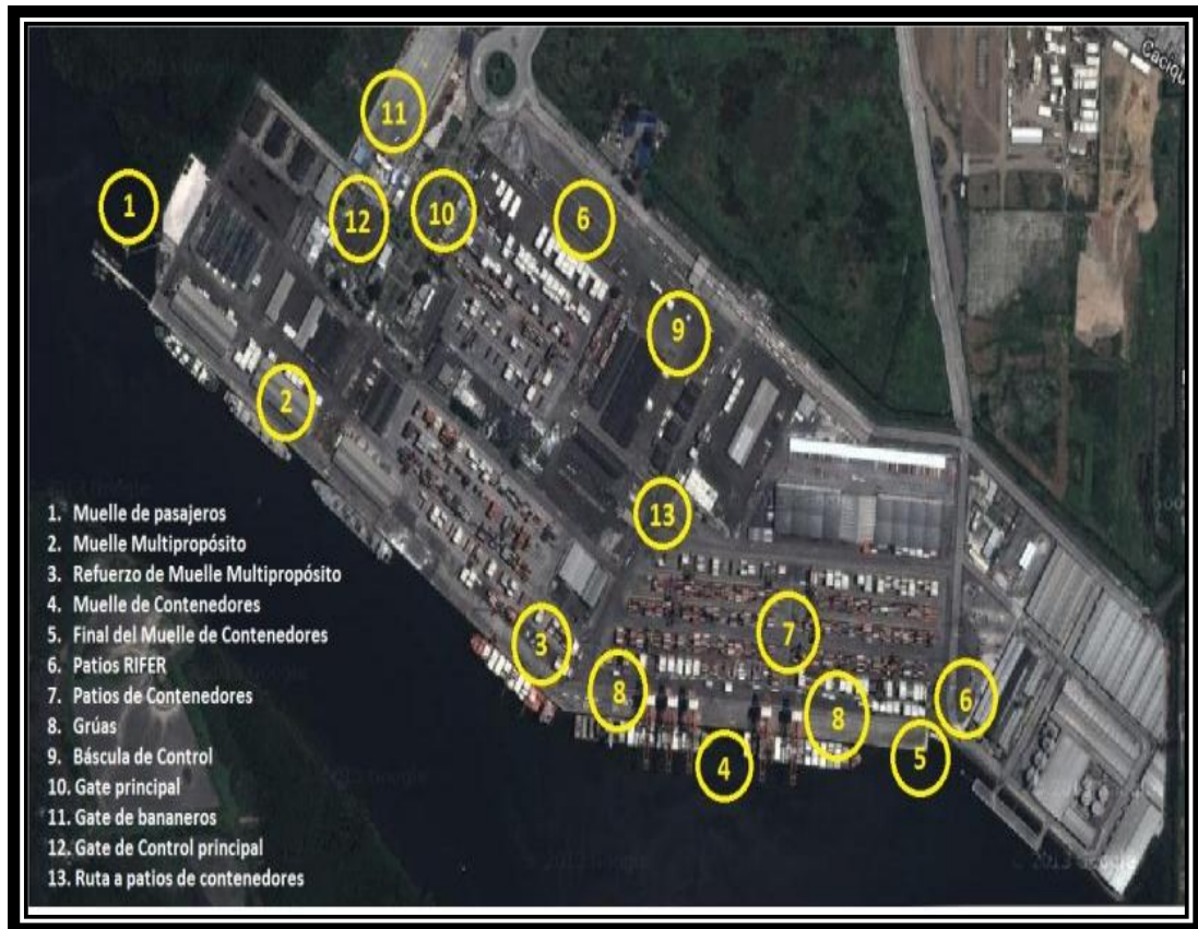
FIGURA 9: INFRAESTRUCTURA DEL PUERTO DE GUAYAQUIL
