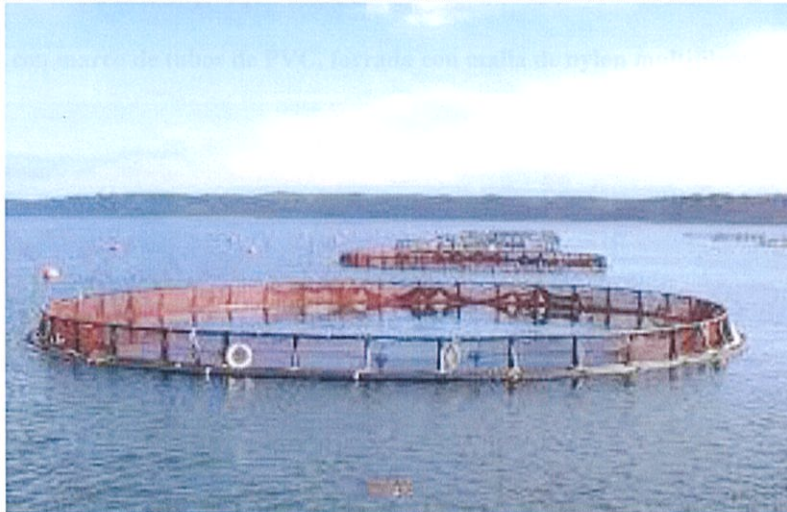
Figura 3: Jaula circular HDPE de cultivo de salmón en las costas de Chile
