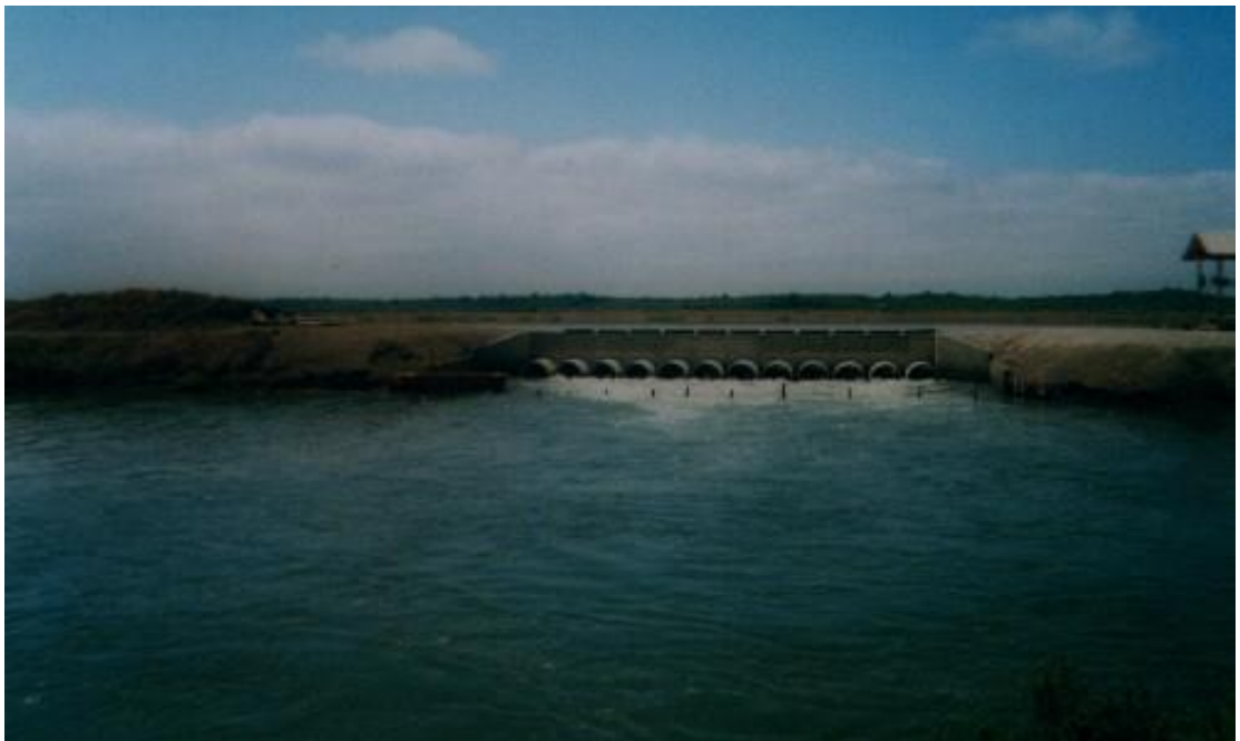
Fotografía 6.- Compuerta de salida del sedimentador B (Vista desde el Reservorio)
