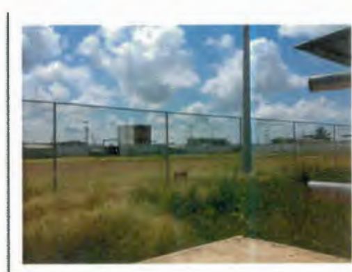
Fot.2 Cancha en mal estado
