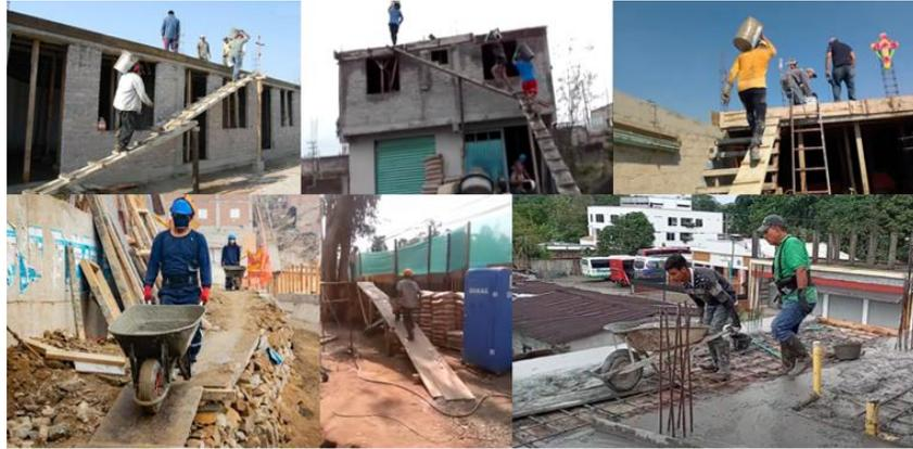
**Figura 1.2 Uso de baldes y carretillas en la construcción (Extraído de: <https://www.youtube.com/watch?v=ryFyRFCIJsk>)**
