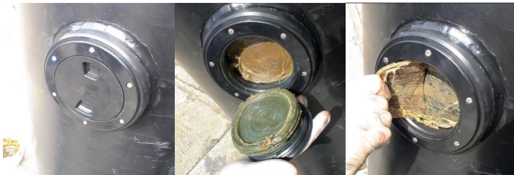
Figura 3.7 Puerto de inspección de las capas de protección en los pilotes.
