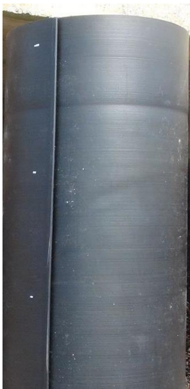
Figura 3.6 Aplicación de la tercera capa de protección en los pilotes hincados en la orilla sin presencia de agua de mar [Elaboración propia]
