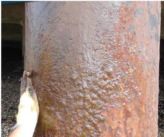
Figura 3.4 Aplicación de la primera capa en los pilotes hincados en la orilla sin presencia de agua de mar [Elaboración propia]
