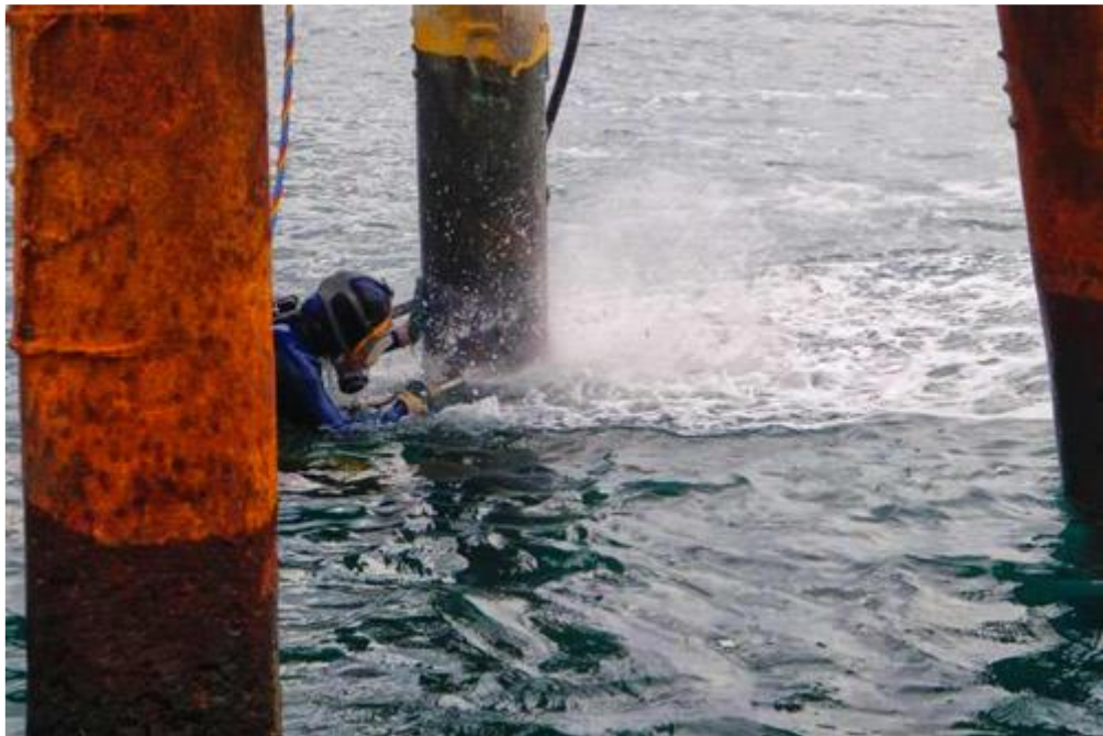
Figura 3.2 Limpieza de los pilotes mediante Hydroblasting [Elaboración propia]
