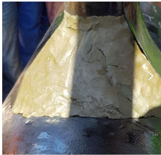
Figura 3.9 Aplicación del engrudo en zonas de difícil acceso de los pilotes que inhibe la producción de bolsas de aire con la segunda capa de cinta [Elaboración propia]
