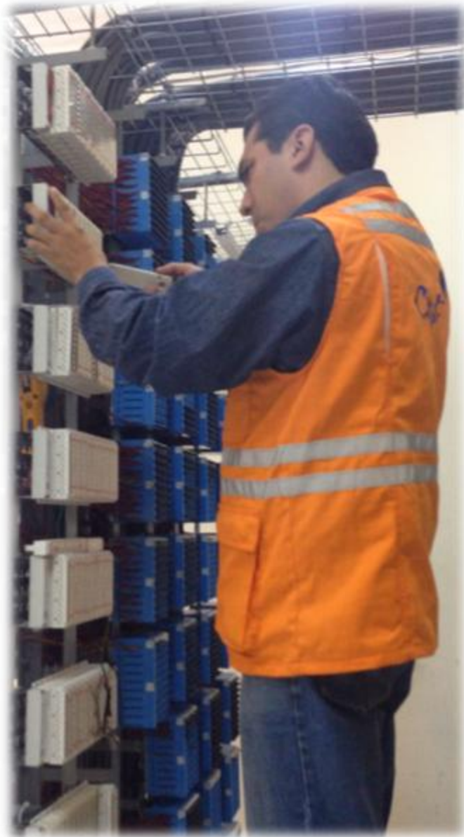
Figura A.2 conexión de nuevo abonado
