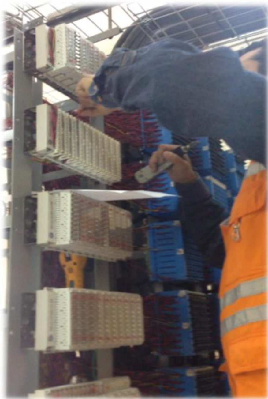
Figura A.4 Conexión de nuevo abonado
